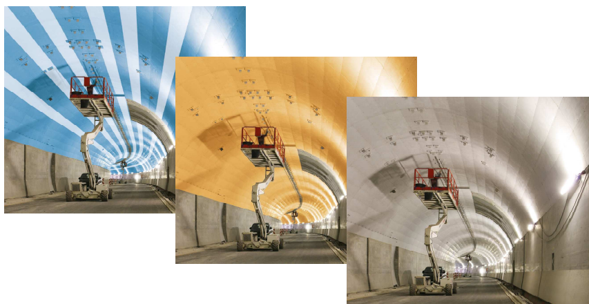
Пример раскраски в подземных сооружениях
